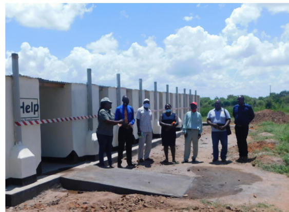
Help rehabilitierte die Latrinen an Schulen nach neuem UN Habitat Standard und versah sie im Sinne des „Building Back Better“-Ansatzes mit Rollstuhlrampen.
